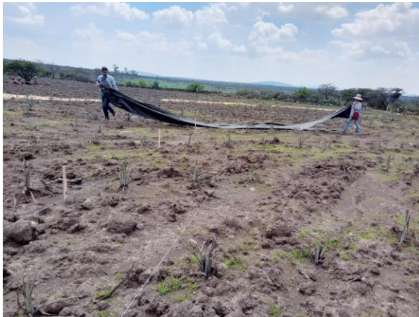
Figura 3. Colocación de malla
