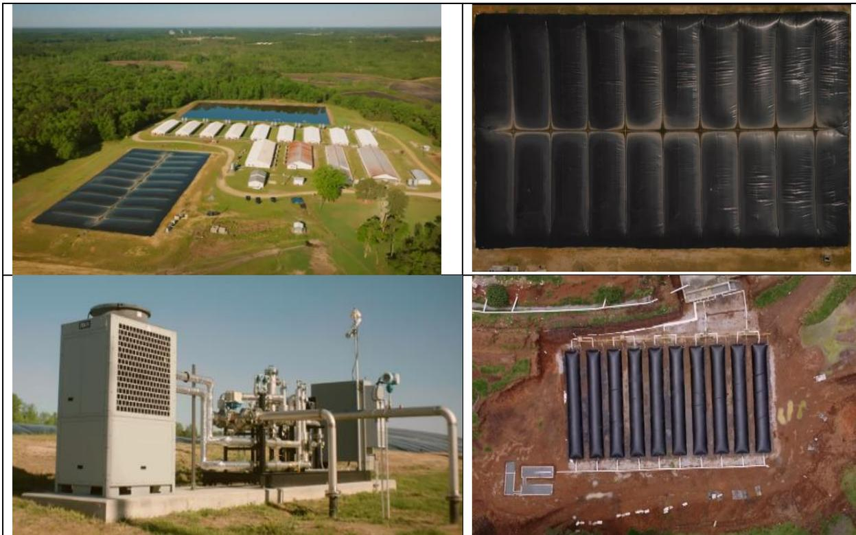
Sistema de biodigestores encadenados en Carolina del Norte y abajo a la derecha en México para 300 cerdas
