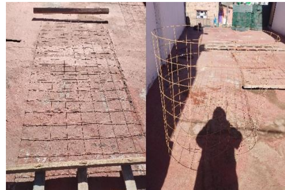
Figura 1. Creación de jaula con malla alambrada
