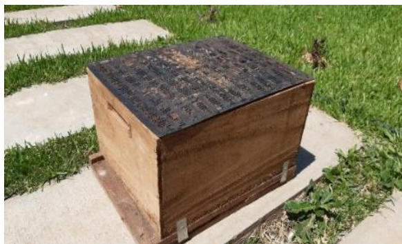
Colocación de la rejilla
