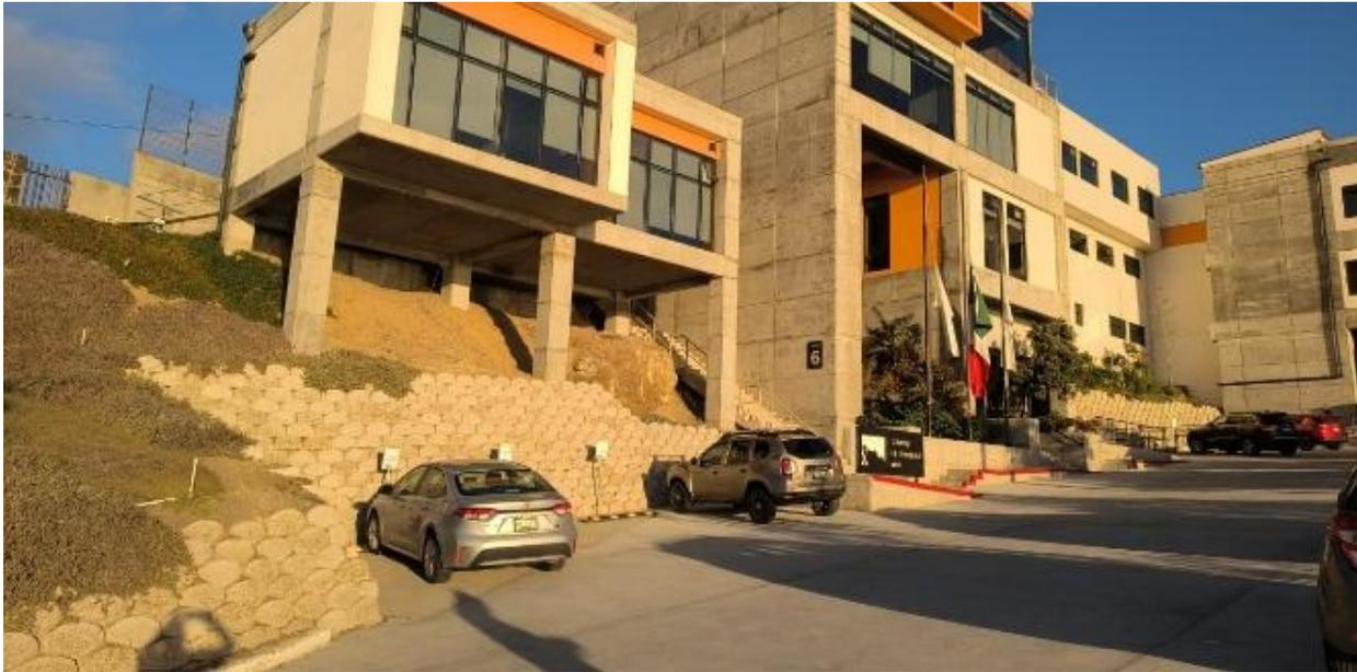
Un muro de contención como su nombre lo indica es para contener tierra, jal, barro, arena, etc. Se construye donde hay laderas, en terrenos con desniveles o inclinados. Su objetivo es evitar erosión, deslizamientos o derrumbes.
