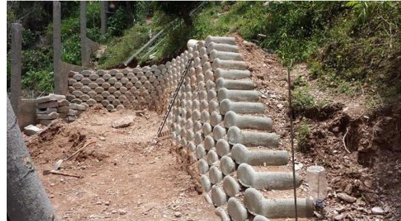
La quinta imagen fue tomada de internet, para mostrar el tipo de bloque modular que tiene en su parte inferior hembra y en la superior macho y de esta manera ensamblan, además tiene una guía de ensamble. Este bloque es fabricado de concreto.
