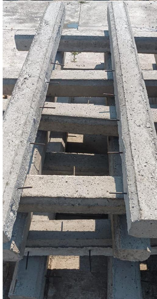
Antes de colocar el castillo, aplicar aceite quemado a los moldes para que no se pegue la mezcla (arena, grava, agua, cemento); la mezcla se debe picar con una varilla y golpear por los lados de los moldes, para una mayor compactación. Después se colocan los arpones de alambón a cierta distancia, según si llevará 4 o 6 hebras de alambre.
